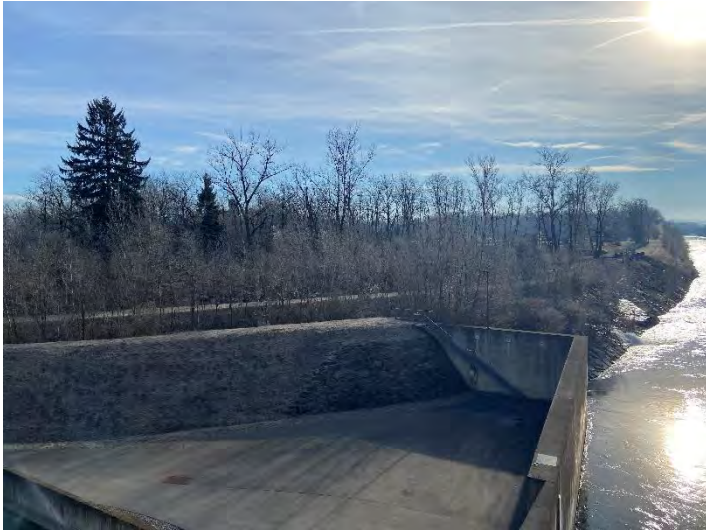
Abb. 19: Kraftwerk Gössendorf, Blick nach Südosten auf die Kläranlage
