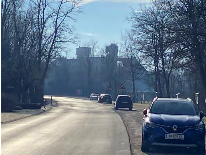
Abb. 14: Blick von Norden auf die Kläranlage
