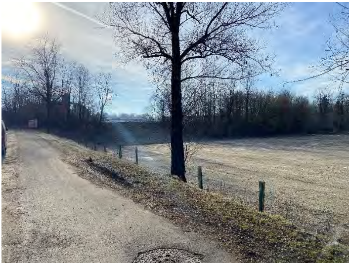
Abb. 17: Erweiterungsbereich nördlich der Kläranlage (Vorklärbereich)
